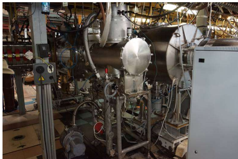
инжектор №2 и пост откачки
