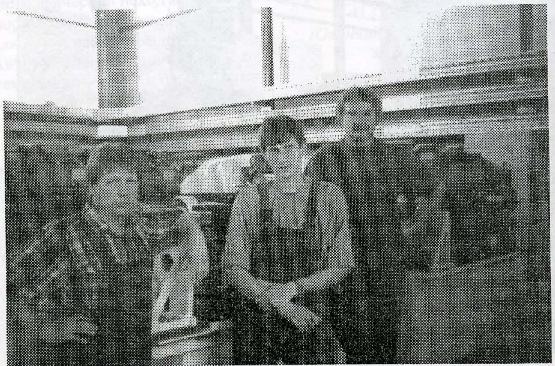
Монтаж вакуумной камеры накопителя BESSY-II (слева направо) Б.Ф.Чирков, Д.В.Подлесный, А.Н.Булыгин.
