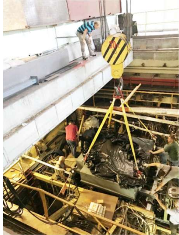
Рисунок 3. Монтаж верхнего адронного калориметра на экспериментальный промежуток ВЭПП-3.
