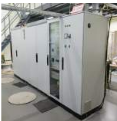
Рисунок 4. Высоковольтный источник анодного и экранного напряжения ламп ТН-781.
