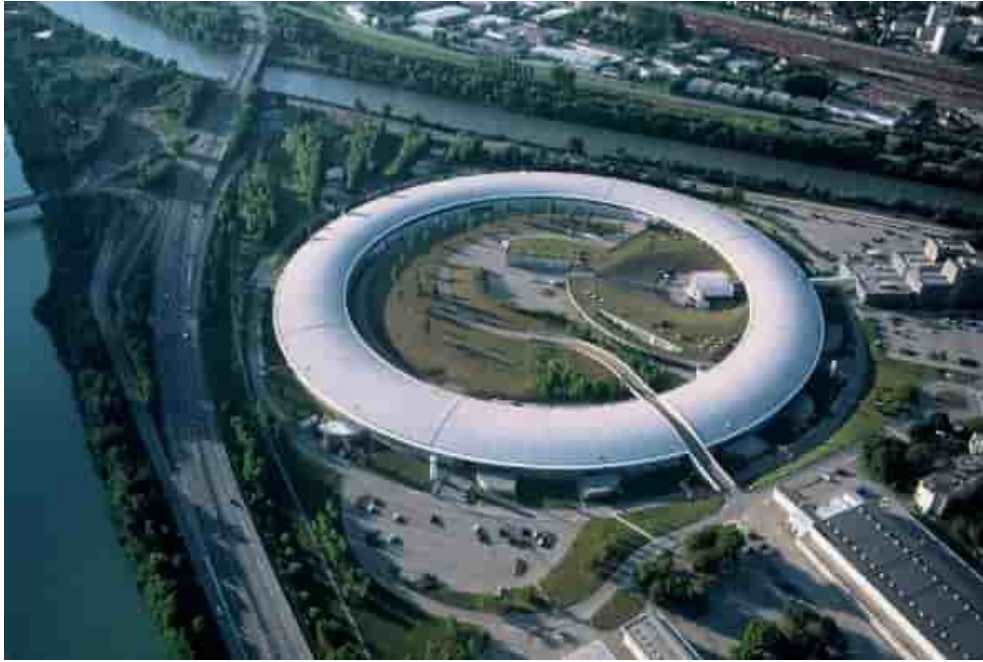
Рисунок 1.6 – Фотография здания ESRF, Гренобль, Франция [16]
